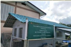
อาคารโซล่าเซลล์ แหล่งเรียนรู้
